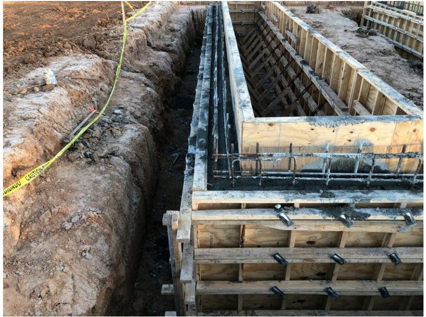
Pour concrete Maintenance Bus lift
